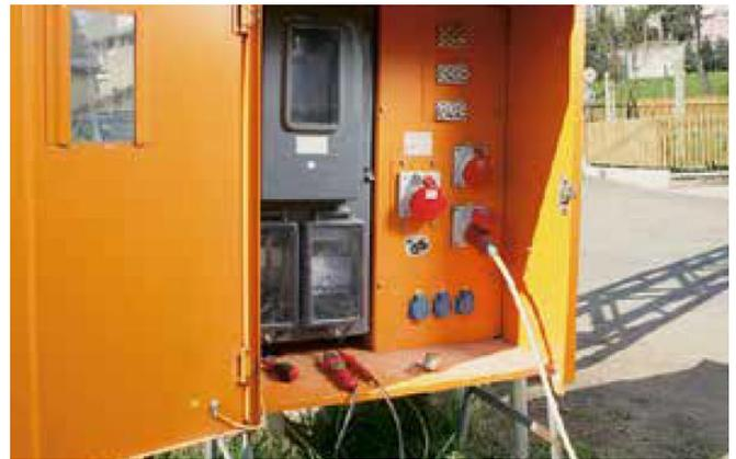
Bild 2 Bauverteilerschrank
