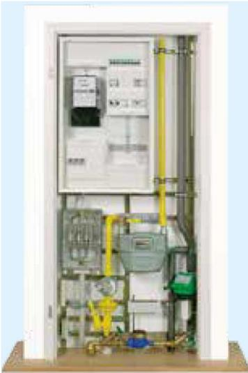
Bild 5 Beispieldarstellung: Platzsparende Hausanschlussnische
